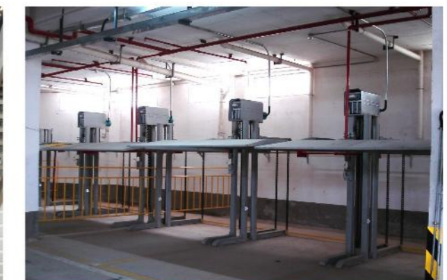
佛山市富景花园地下停车库
